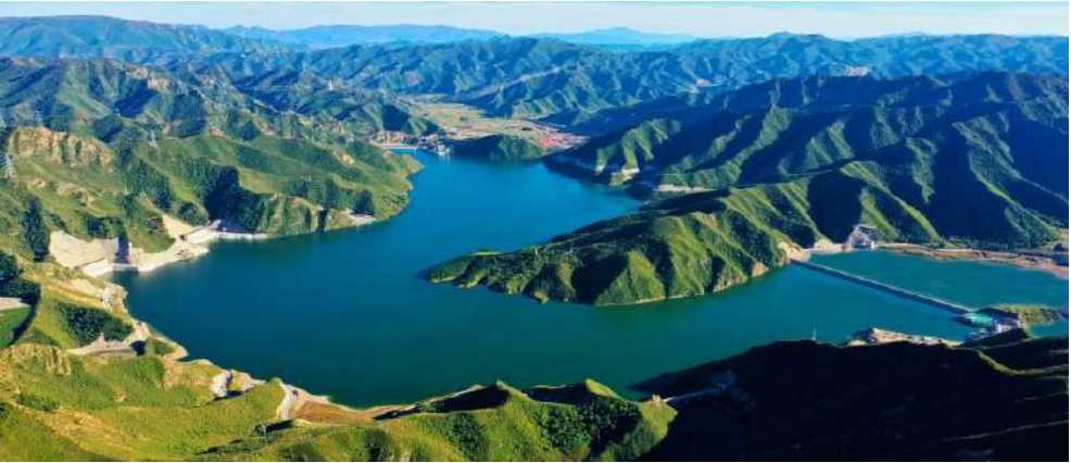
Fengning Pompaj Depolama Elektrik Santrali – Çin
